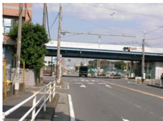
④ 国道246高架橋下「上草柳」交差点を渡って左折し、側道を直進。
